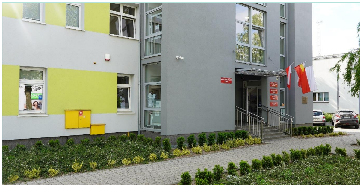
Zdj. 4 Budynek Urzędu przy ul. Dworcowej 3
